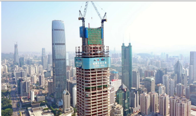
▲9月13日,华南公司承建的深圳城建大厦项目核心筒主体结构顺利封顶。 王浩业/摄
