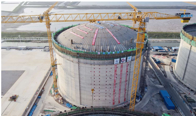
▲9月9日,中建电力承建的国内首批陆上大型薄膜罐工程,天津南港LNG项目10号储罐顺利完成顶升。 陈国琴/摄
