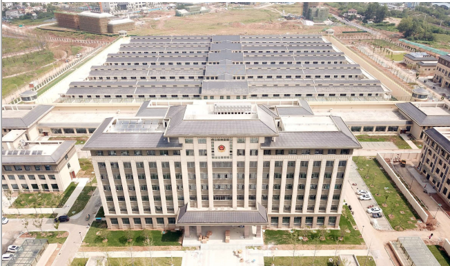
▲8月29日,三公司承建的襄阳市公安局“两中心两基地”项目EPC总承包工程顺利竣工交付。 周莹/摄
