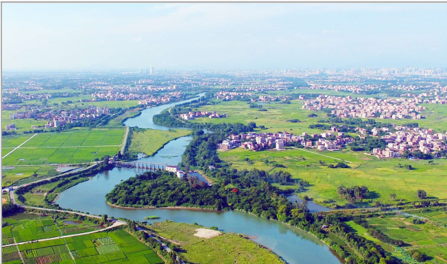
▲8月25日,华东公司参建的江苏江阴农村生活污水治理项目全面竣工。 郝帅/摄
