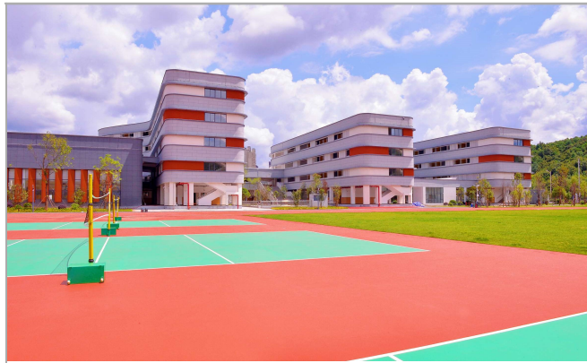
▲近日,西南公司承建的昆明经开区黄土坡片区配套九年一贯制学校建设项目全面竣工。 左傲 / 摄
