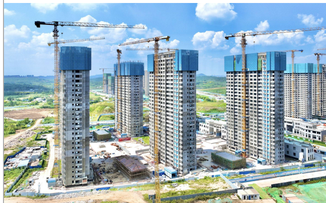
▲9月16日,华东公司承建的南京孟北保障房项目全面封顶。 李天心 / 摄
