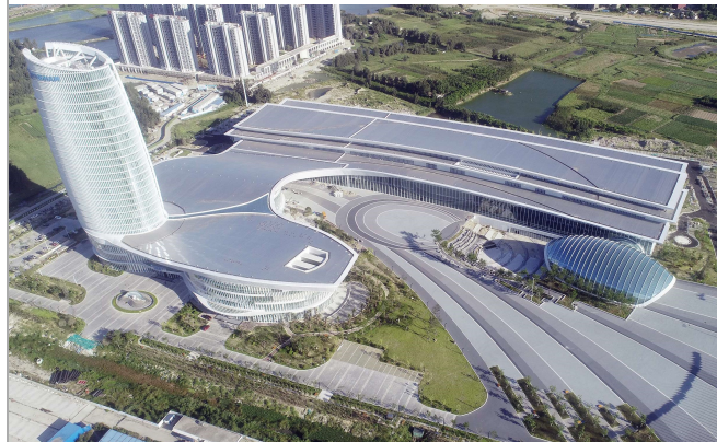
▲10月14日，华南公司承建的福建平潭海洋国际会展中心项目通过竣工验收。彭伟豪 / 摄
