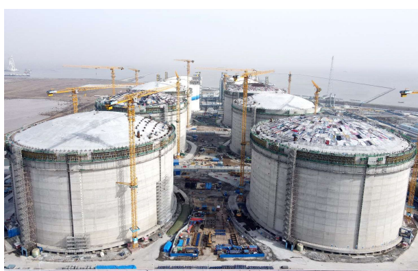
▲12月20日,全球单个储罐容量最大的中海油盐城绿能港一二期扩建工程罐体穹顶全部浇筑完成。 陈国琴 李浩 / 摄
