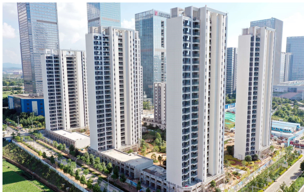
▲12月12日,西南公司承建的昆明紫云景宸项目竣工。 保成 / 摄
