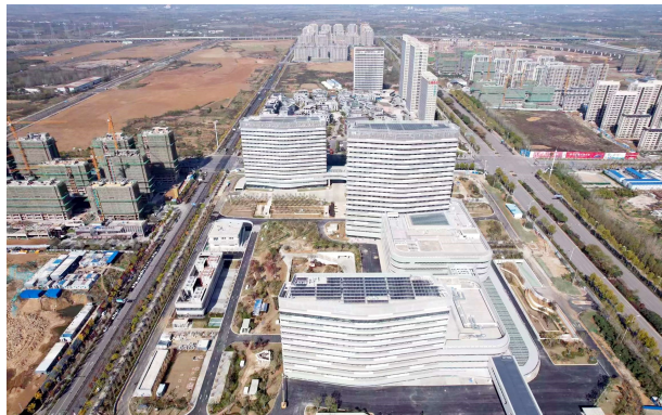
▲11月15日,三公司承建的合肥市长丰县北城医院项目二标段顺利通过竣工验收。 代增斌 陈征宇 / 摄
