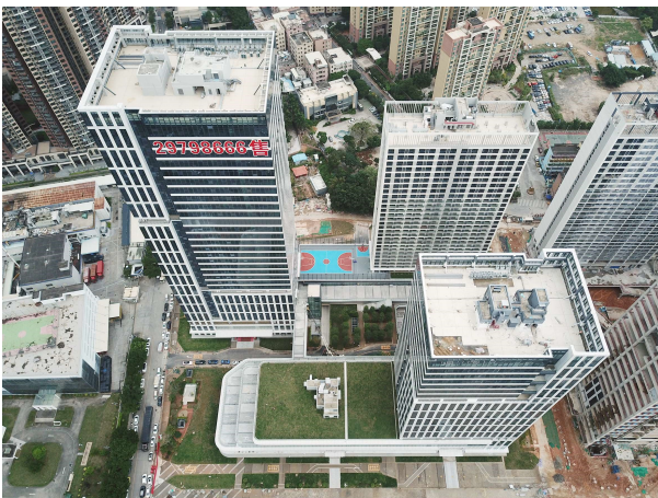
▲12月20日,一公司华南分公司承建的星展广场项目顺利通过竣工联合验收。 张博文 / 摄
