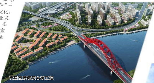
天津市跨海河大桥工程
