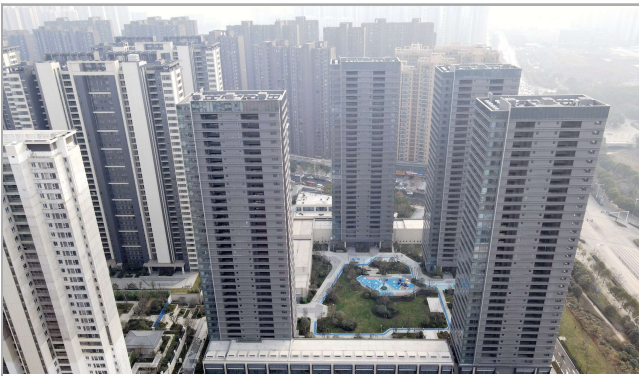
▲12月29日,三公司承建的武汉当代君悦湾项目(三期)西地块正式交付使用。周莹 / 摄
