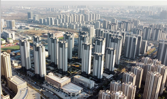
▲12月24日,华东公司承建的合肥贾大郢拆迁安置复建点二期项目竣工。章东东 / 摄
