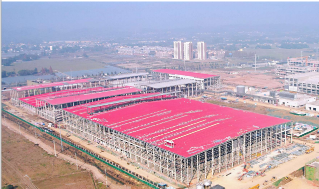
▲12月21日,西南公司承建的四川眉山中创新航锂电正极材料项目全面封顶。戴理兵 / 摄
