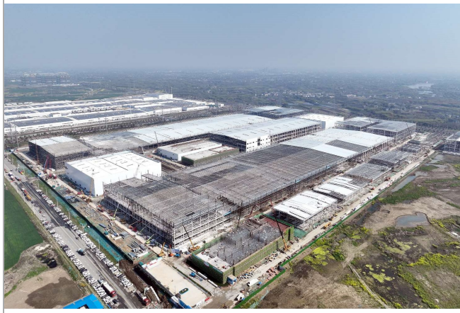
▲4月9日,华东公司承建的常州翔峰新能源产业园项目一期全面封顶。 李天心 / 摄
