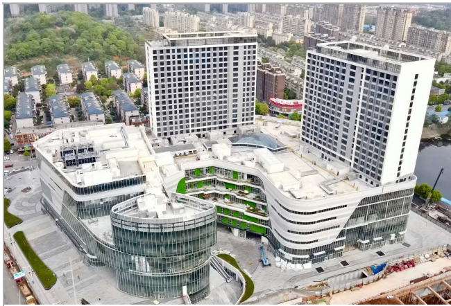
▲4月3日,三公司承建的长沙汇金中心项目裙楼(商业广场)顺利移交。 周莹 / 摄
