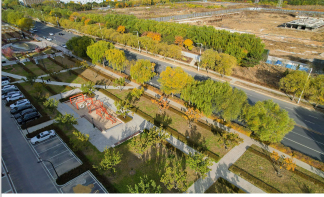
▲11月10日,由北方公司承建的辽宁沈阳中德园新能源汽车产业园基础设施配套项目43个口袋公园投入使用。 刘浩东 / 摄
