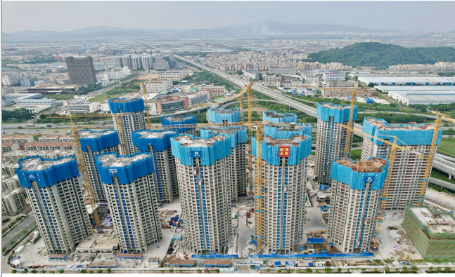
▲11月13日,由华南公司承建的广东珠海金湾区公共租赁住房及人才公寓项目主体结构全面封顶。 苏善南 / 摄
