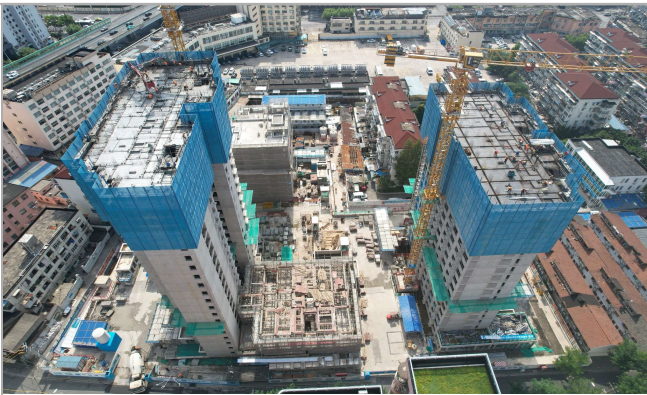
▲11月8日,由华东公司承建的上海静安区谈家桥城市更新项目主体结构全面封顶。 朱兆清 / 摄
