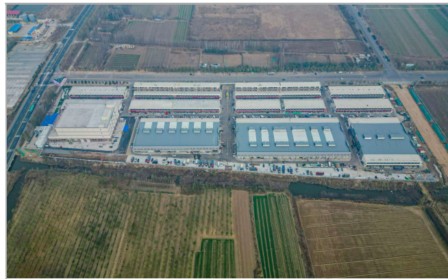
▲11月14日,由二公司承建的中国农批乐陵农产品智慧物流园(一期)工程总承包(EPC)顺利通过竣工验收。 马黎明 / 摄
