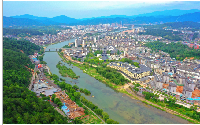
▲11月13日,由华南公司承建的浙江龙泉城市文化客厅项目全面竣工。 周传建 / 摄
