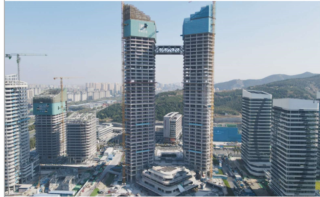
▲12月12日,由北方公司承建的国惠科创中心项目空中连廊在172.5米高度完成高空提升。 王博涵 / 摄
