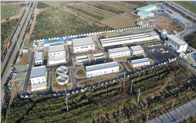
▲12月12日,由华东公司承建的安徽宿州经开区地表水厂项目竣工。章东东/摄
