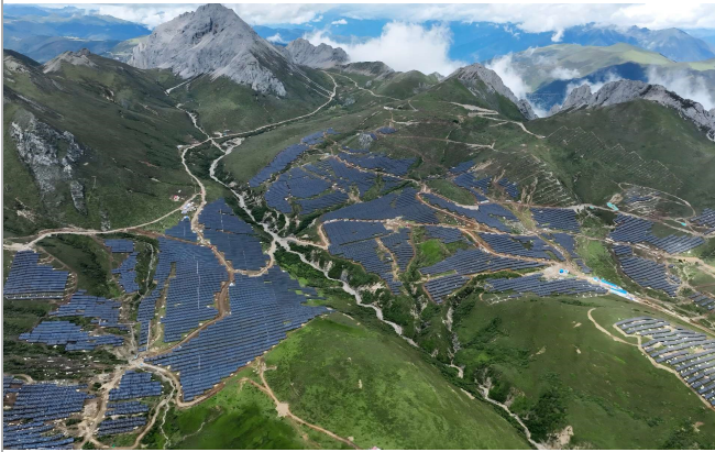
▲12月15日,由西南公司承建的四川凉山卡基娃水电站水光互补210MW光伏项目全面并网投产。王柯宇 管小圣/摄
