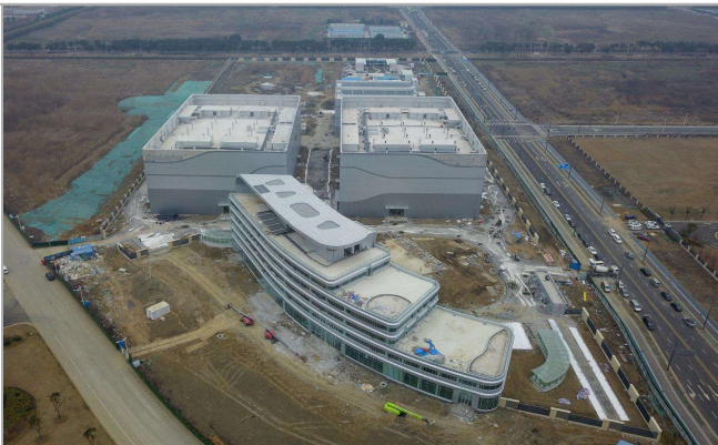
▲近日,由三公司承建的中国移动长三角(无锡)马山数据中心服务器生产组装及通讯工程项目竣工。 张帆 / 摄
