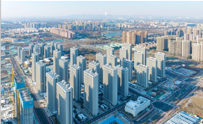
▲近日,由华东公司承建的南京绿洲保障房E地块项目竣工。 李天心 / 摄
