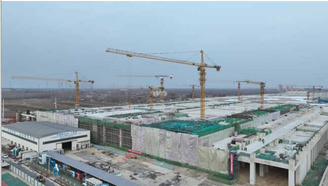
▲近日,由华北公司承建的雄安新区至北京大兴国际机场快线项目五标段联合检修库全面封顶。 李昊天 / 摄
