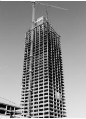
▲近日，安装公司大连中国供销集团再生资源交易所钢结构工程完成钢结构 8500 吨的钢结构安装，施工高度至 170 米，主体结构基本完成。为确保春节前能顺利封顶，目前该工程已进入冲刺阶段。齐洪涛 / 摄
