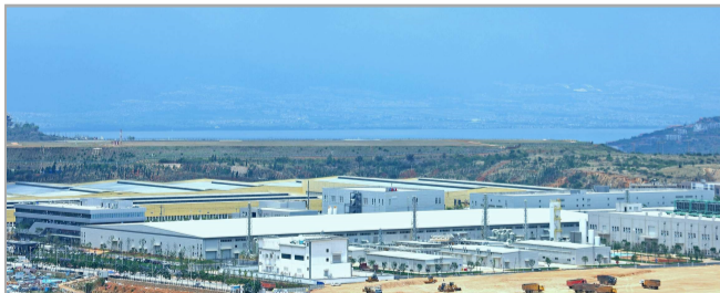
▲近日,由西南公司承建的大理华晟新能源高效异质结电池和组件智能制造项目(一期)全面交付。 保成/摄
